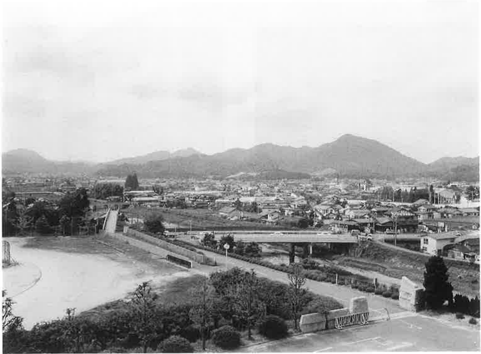
調査地遠景（北から）
