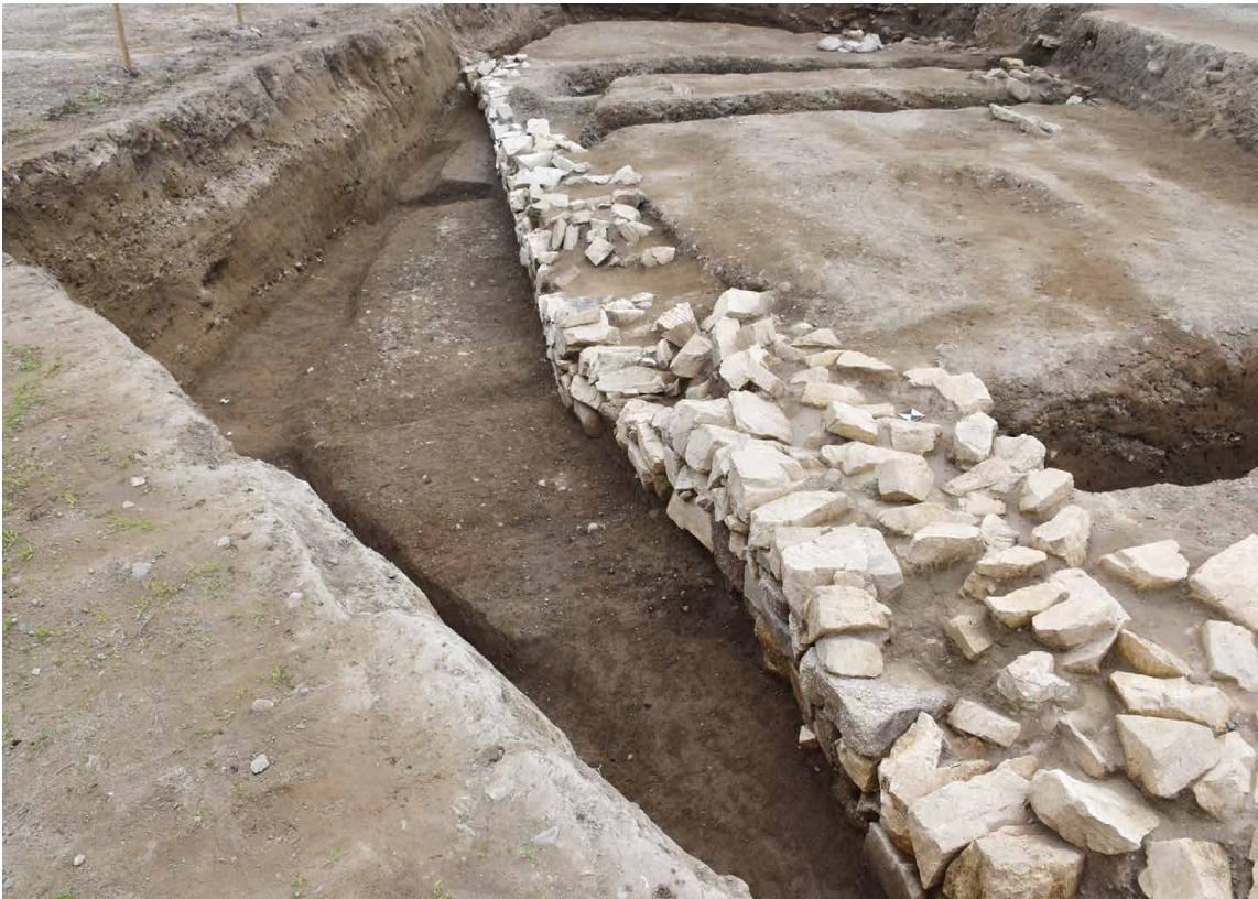
船着場遺構石垣検出状況（西から）
