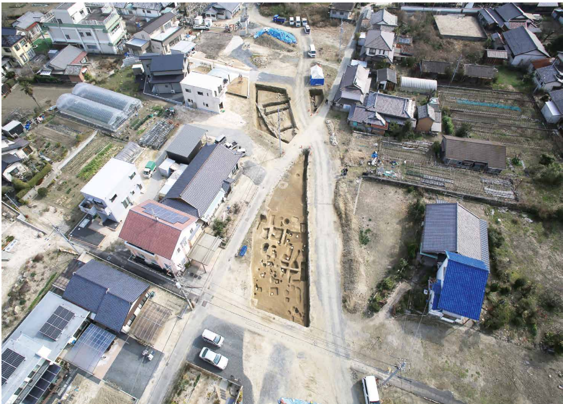
中津居館跡調査区遠景（第16次調査東側）（西から）
